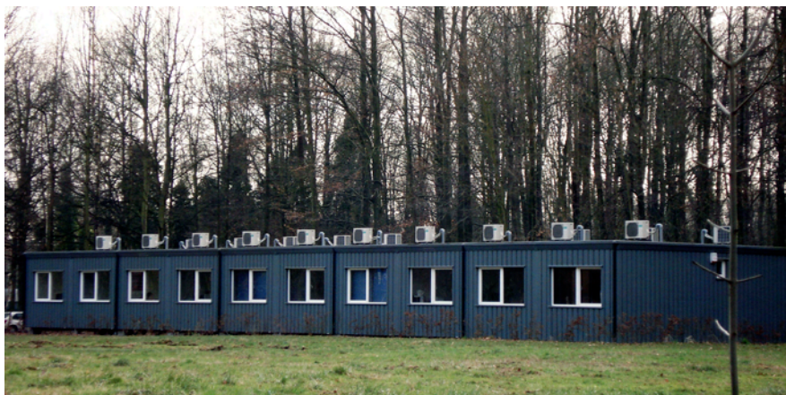
Réalisation récente au moyen de volumes modulaires DEGOTTE à l'endroit appelé « Traverse des architectes » au Sart Tilman. On notera la présence d'un dispositif de conditionnement d'air au-dessus de chaque module.
