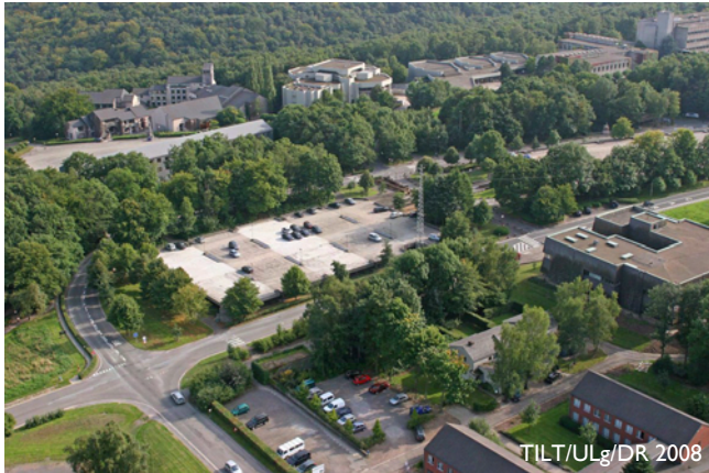
Vue d'hélicoptère de la partie densément bâtie du domaine du Sart Tilman
