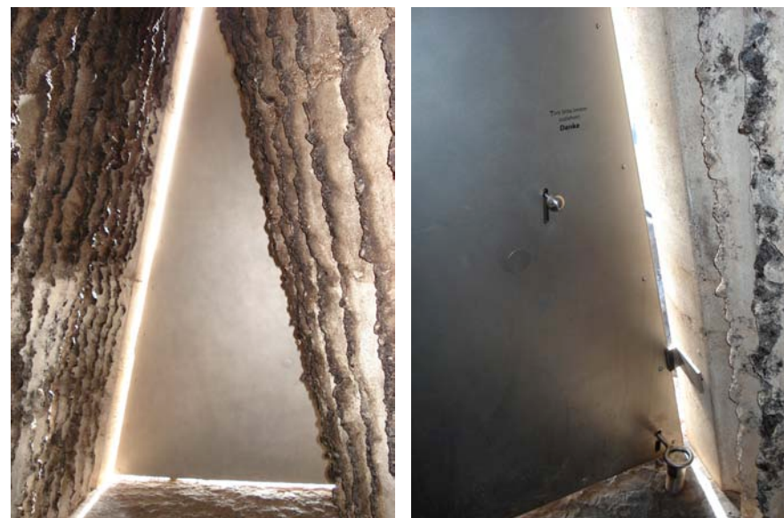
Fig 6 et 7 la porte d'entrée en acier inoxydable, pivotante autour d'un axe vertical et son système astucieux de fermeture.
