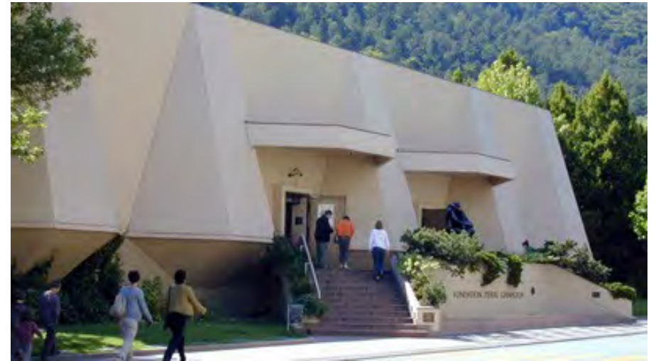
Entrée de la Fondation et du Musée Gianadda à Martigny.
